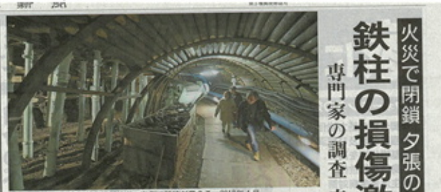
火災で閉鎖夕張の模範坑道 鉄柱の損傷激しく
