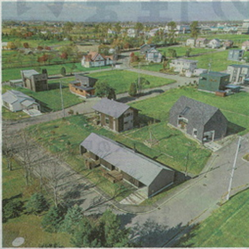
道産住宅が並ぶ空知管内南幌町の「みどり野」住宅地。
