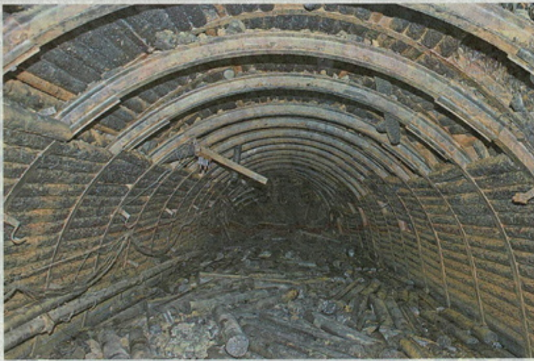
坑道内にたまったがれき。天井部分の損傷も激しい (夕張市提供)
