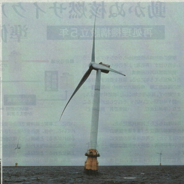
英北東部スコットランド沖25kmの海に浮かぶ「浮体式洋上風力発電所」。風車の回転軸までの高さは98m。真下から見上げると巨大な作業船で浮体式の特徴を説明するエクイノールのベン・ローソンさん
