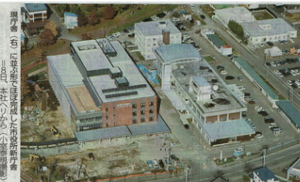
現庁舎(右)に並ぶ形でほぼ完成した新庁舎新庁舎(左)に並ぶ形でほぼ完成した新庁舎新庁舎(左)に並ぶ形でほぼ完成した新庁舎
