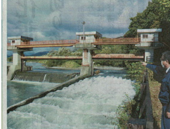
水門などを備えた浦河町姉茶地区の取水施設。地域の農家が持ち回りで管理している=10月中旬
