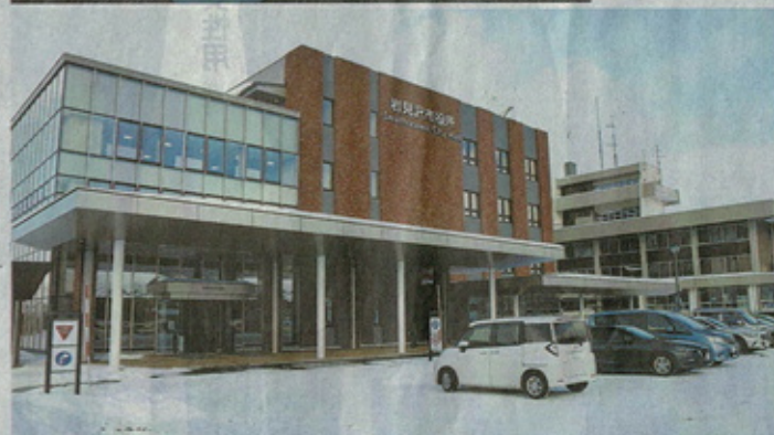
並んで立つ市役所の新庁舎(手前)と現庁舎。1965年から利用してきた現庁舎は今年28日で業務を終え、来年1月から解体。新庁舎は2019年10月に着工し、11月末に完成。総工費は約62億円
