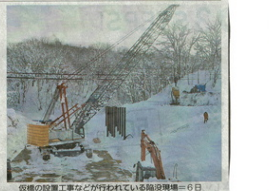
仮橋の設置工事などが行われている陥没現場=6日
